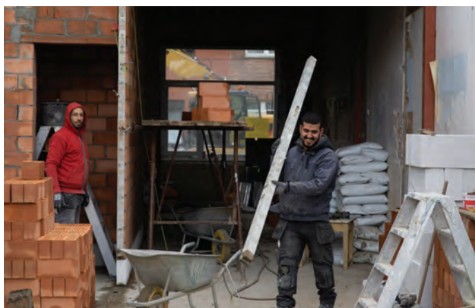
Een renovatieproject van Collectief Goed. © Ken Stoffels
