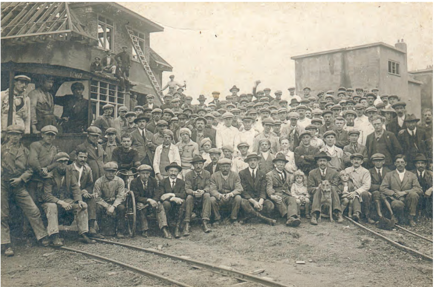
Bouwwerkers en toekomstige bewoners tijdens de bouw van de tuinwijk Kapelleveld in Sint-Lambrechts-Woluwe (1923). Dit woonproject van meer dan 400 woningen werd gerealiseerd door de wooncoöperatie La Cité Jardin du Kapelleveld naar het plan van Louis Van der Swaelmen. Het project bevat bovendien een school, kerk, feestzaal, bibliotheek, sportterreinen, speelpleinen, winkels en een treinstation. Bron: Collectie Jos Kumps.
